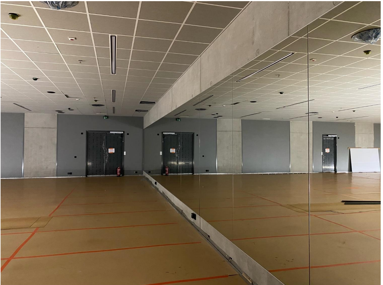
Kuva 1 Liikuntatilojen peili-asennukset käynnissä
