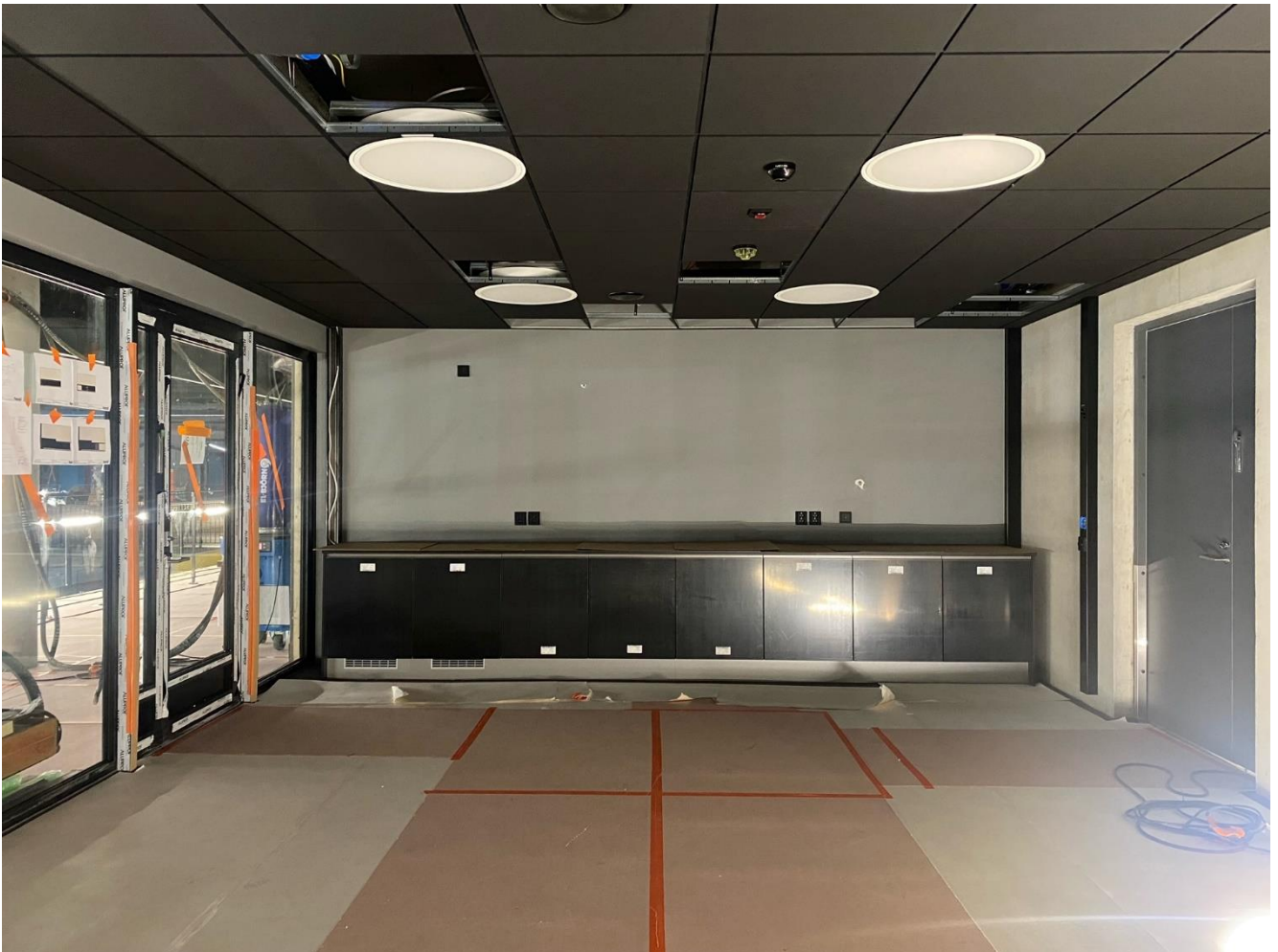
Kuva 2 R2 2krs monikäyttötilan kalusteasennus valmistunut vk 5
