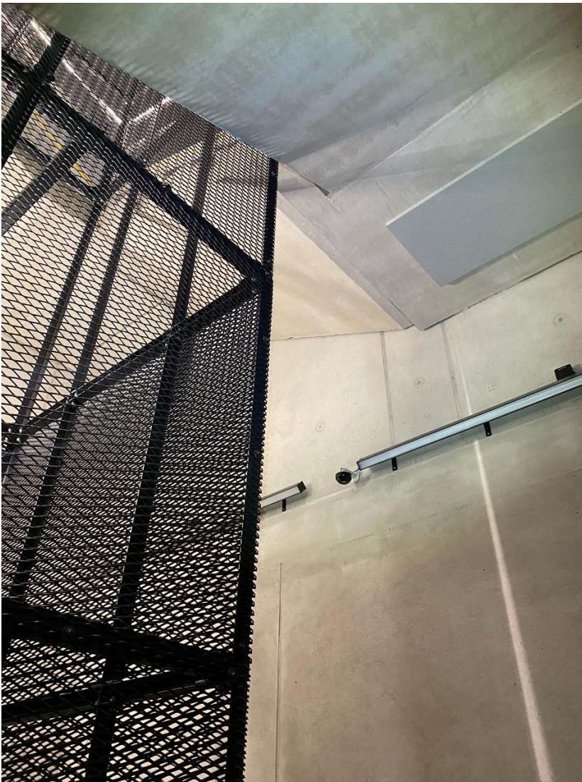
Kuva 1 R2 porraskäytävissä asennettu verkkoseiniä ja valaistuksia
