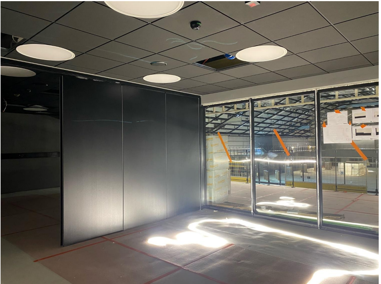
Kuva 1 R2 2 krs monitoimitilan siirtoseinä asennettu
