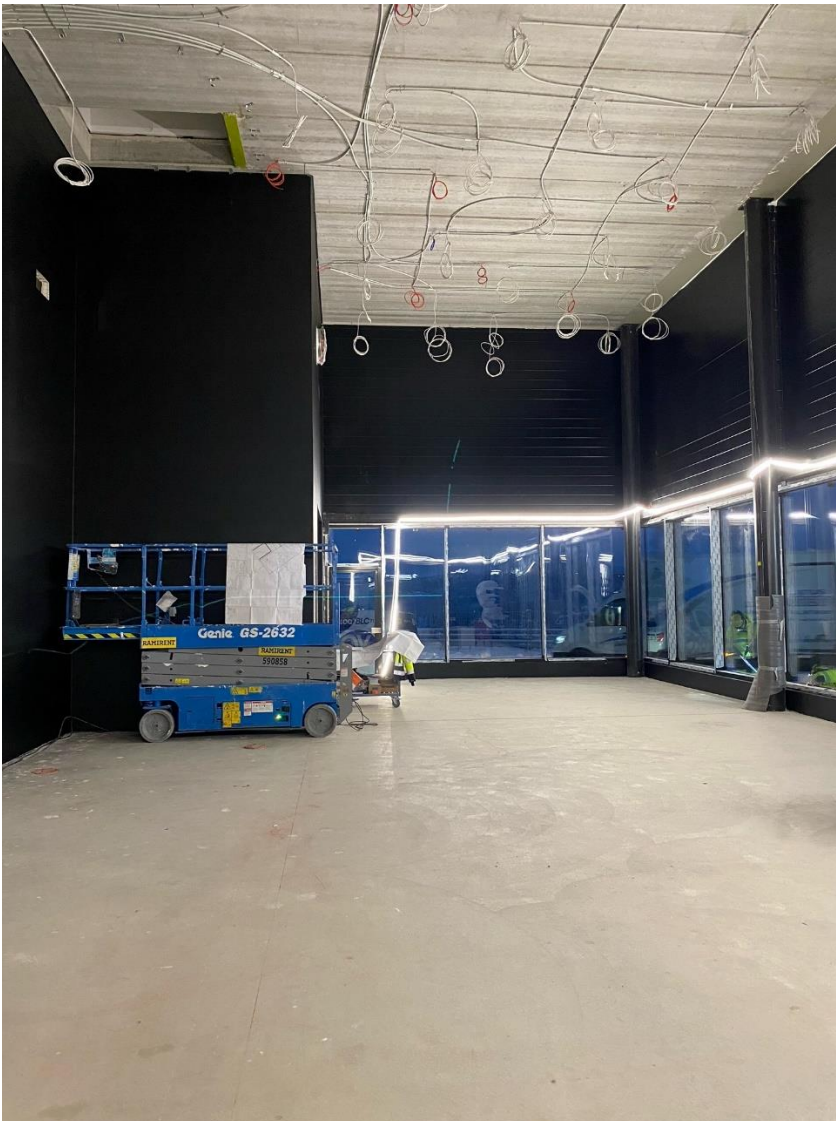
Kuva 1 R1 seinämaalaukset valmistuneet
