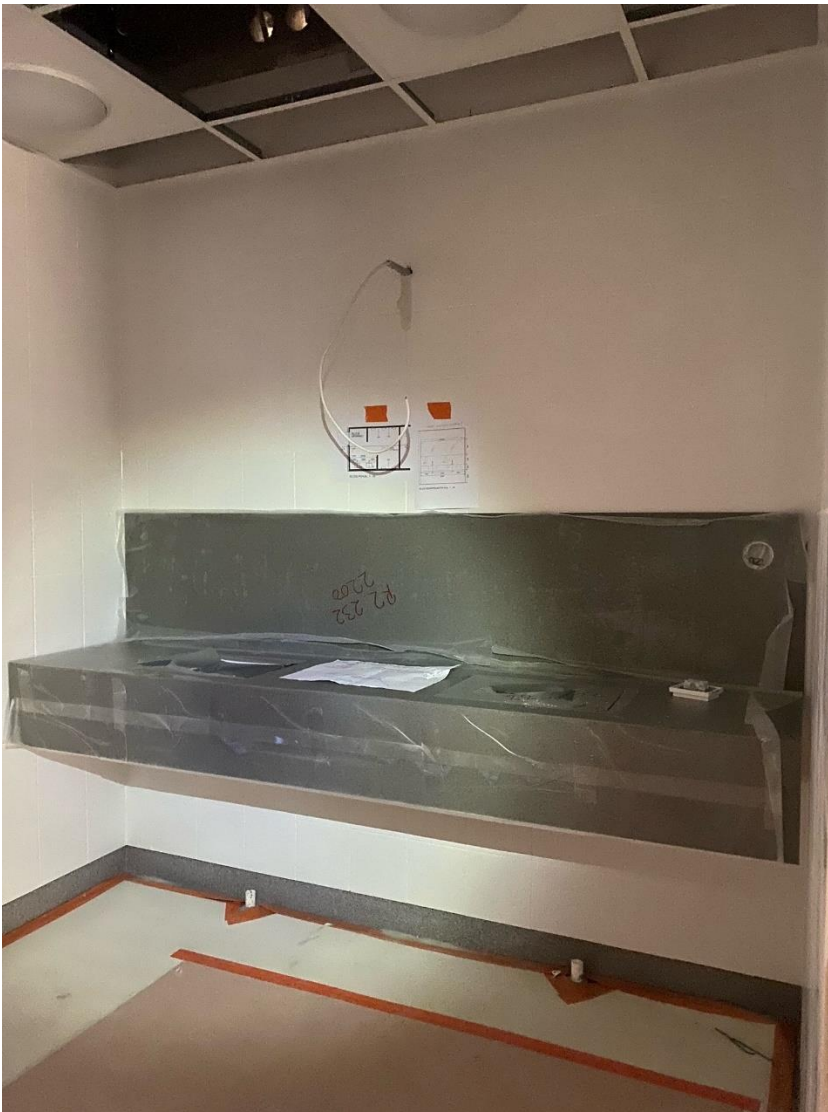
Kuva 1 Yleisö WC tilojen allastasot asennettu viikolla 48
