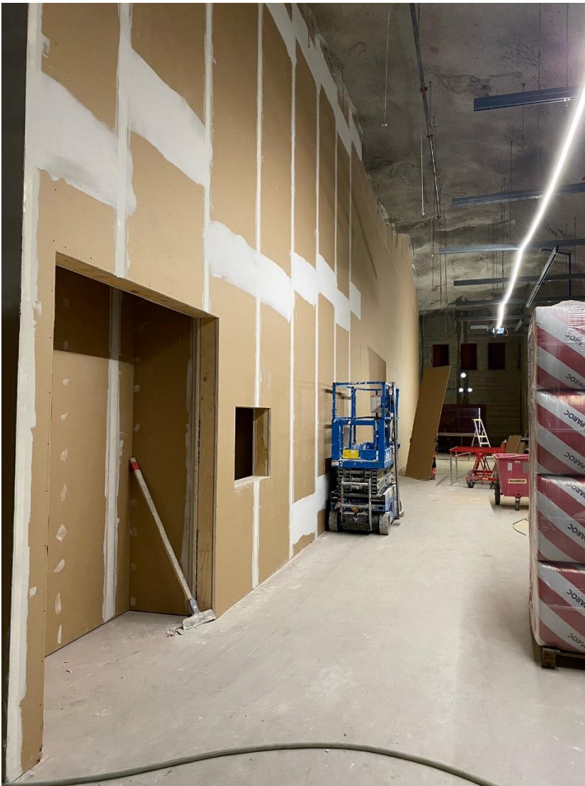
Kuva 2 T6 väliseinätyöt pääosin valmiit
