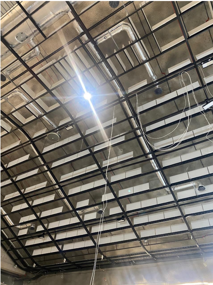
Kuva 1 H1 alueella akustoivat Paffle asennukset käynnissä
