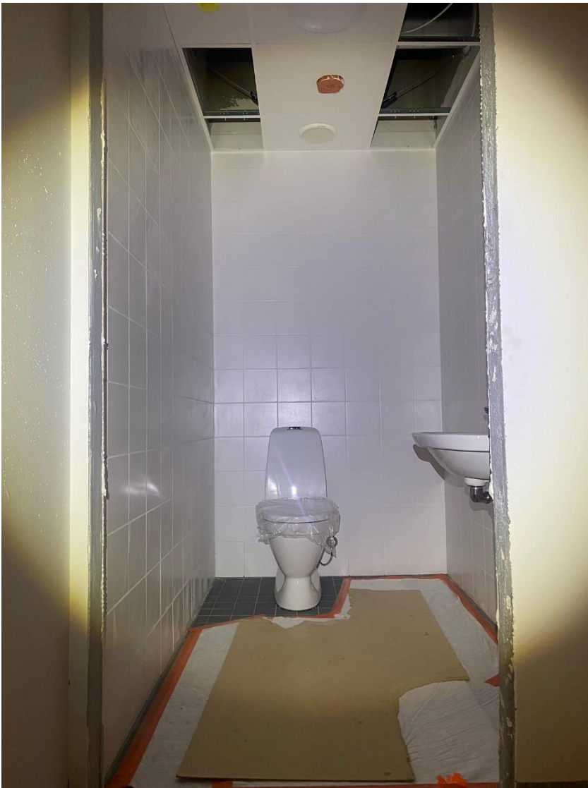
Kuva 2 R2 alueella on tehty malliasennus LV kalustuksesta
