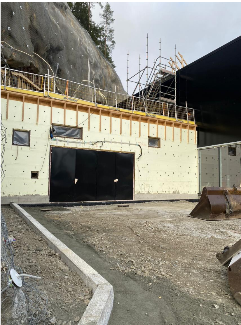
Kuva 1 R1 teräsovia asennettu ja piha-alueen työt käynnistyneet reunakivien asentamisella
