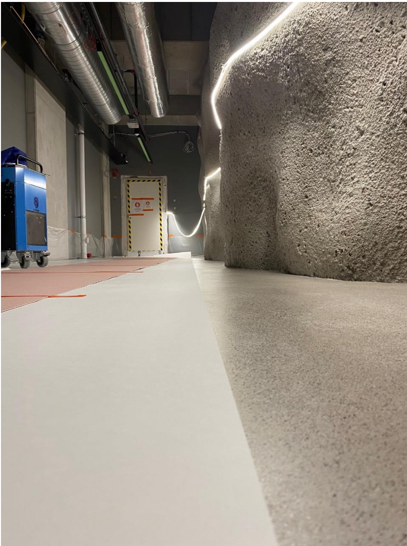
Kuva 2 R2 ja H2 käytävien betonilattioita hiottu ja hiontatöiden jälkeen lattiat suojattu
