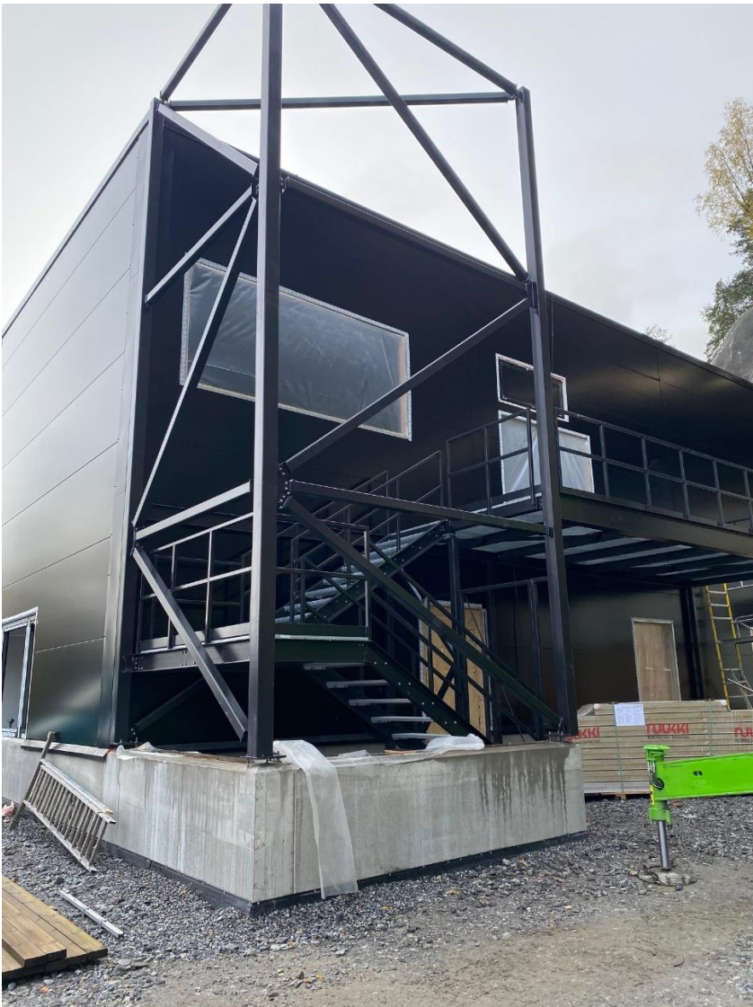
Kuva 1 R1 ulkopuolen IV-konehuoneeseen menevä teräsporras asennettu
