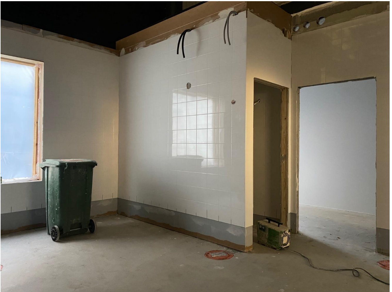
Kuva 2 R1 alueella seinälaatoitukset käynnissä
