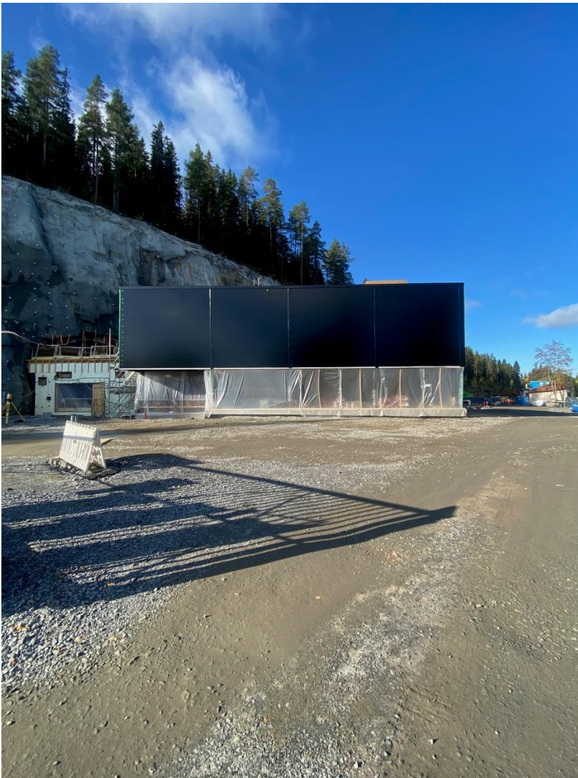
Kuva 1 R1 sääsuoja on poistettu viikolla 40 suunnitelmien mukaisesti
