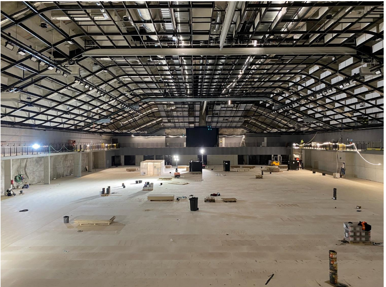
Kuva 2 H1 lattia-asennus alkanut viikolla 2 ja levytys vaihe on pääosin valmistunut
