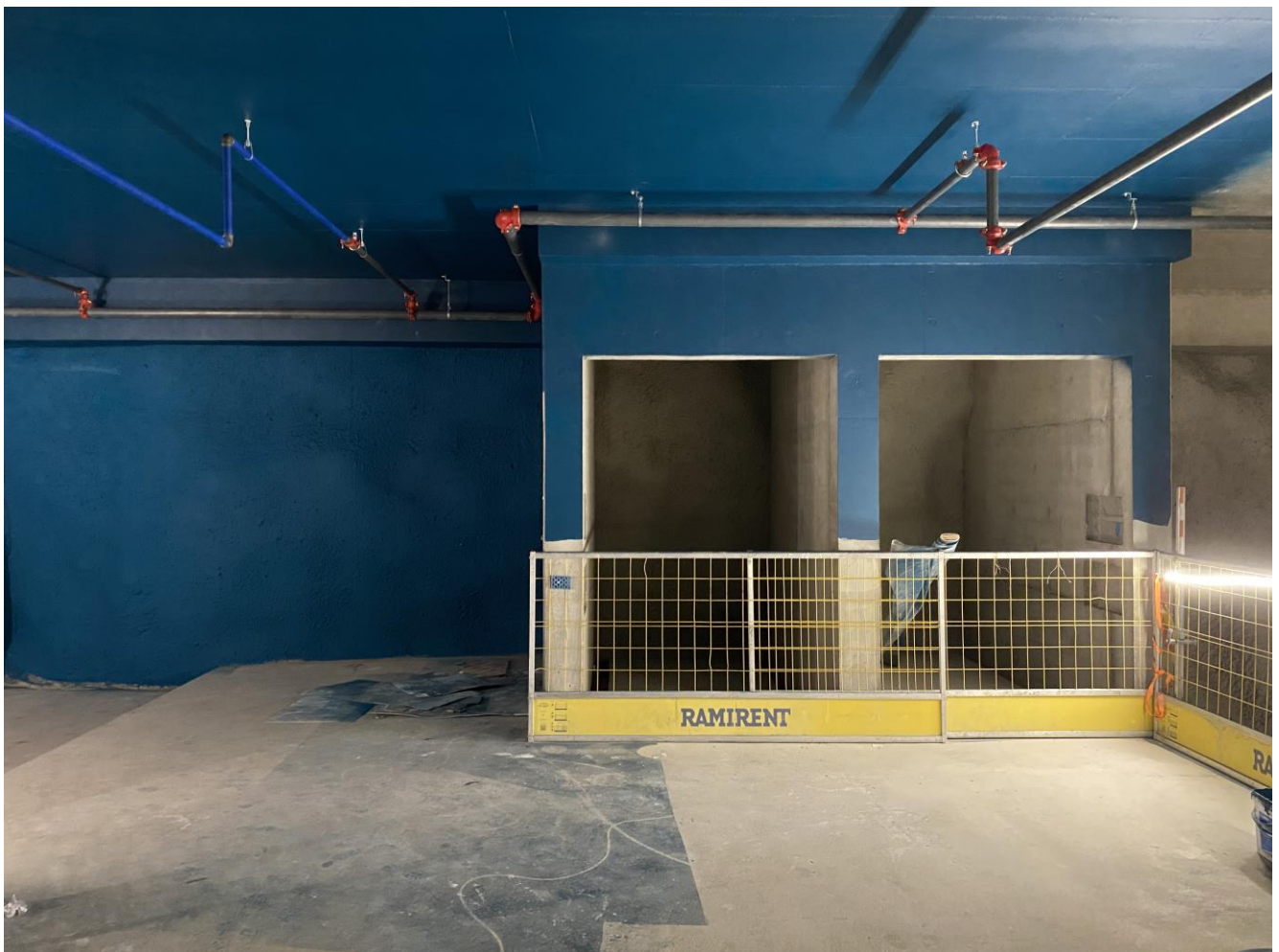
Kuva 1 T4 hissikuilut, hissien asennus alkavana työvaiheena
