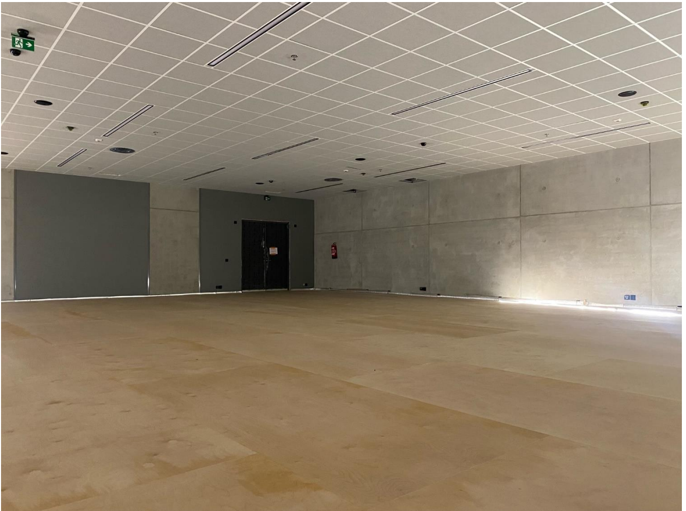
Kuva 1 H2 1krs lattia-asennus alkanut viikolla 2
