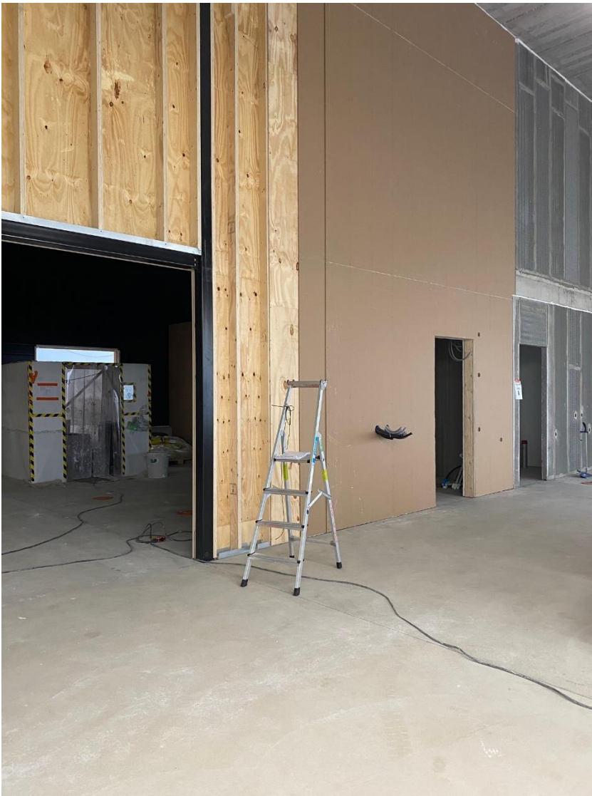
R1 väliseinätyöt käynnissä
