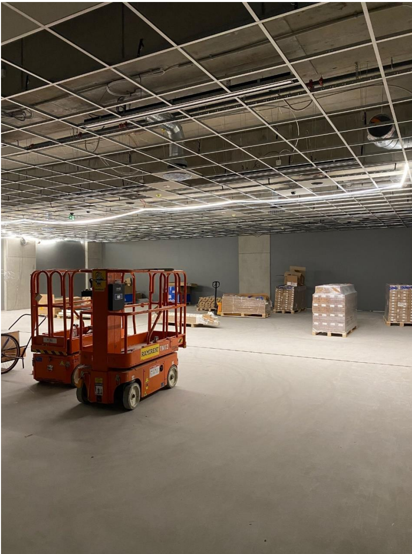
H2 1. krs alakattorunkoja asennettu
