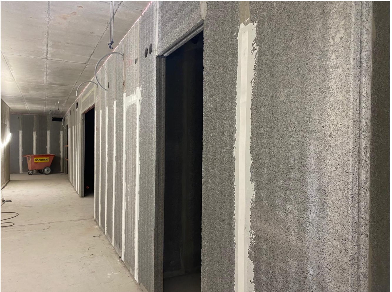
T2: muuratut väliseinätyöt valmistuneet
