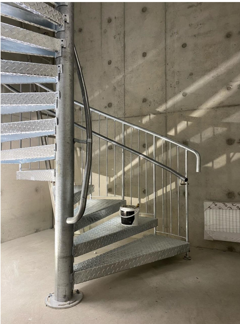
H2-alueelle on asennettu teräskierreporras.
