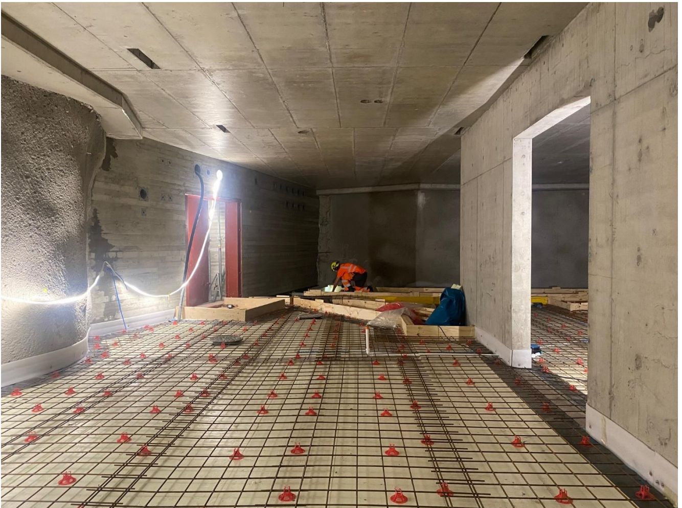
T2: lattian asennustyöt käynnissä.
