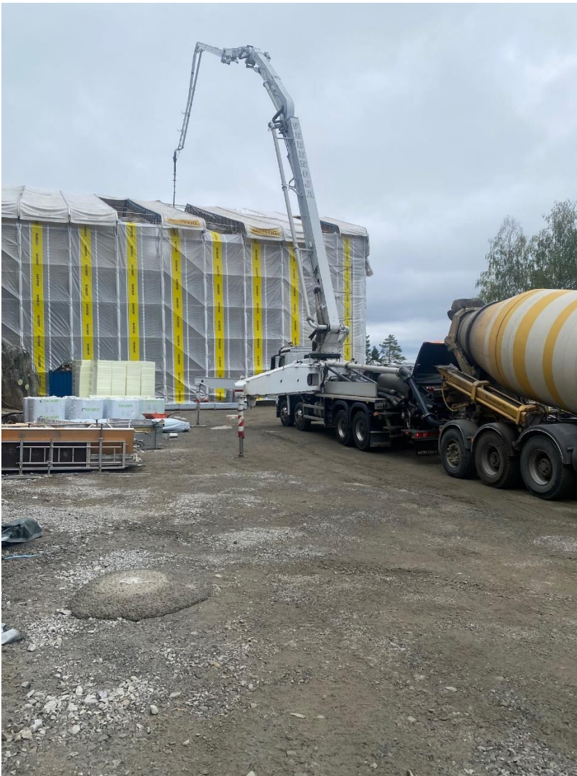
R1: sääsuoja pääosin asennettu ja katon betonivalut käynnissä.
