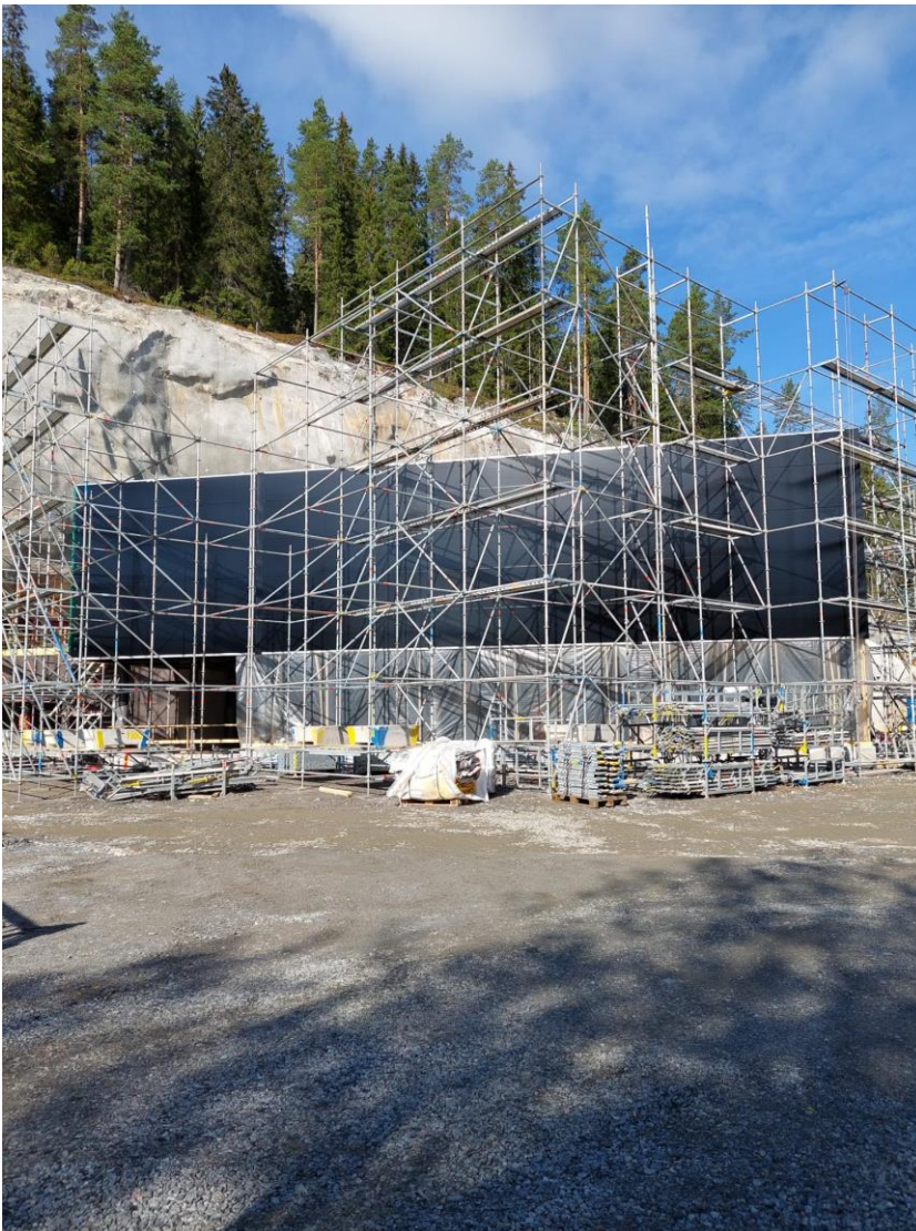
R1: sääsuojan asennus on käynnissä.
