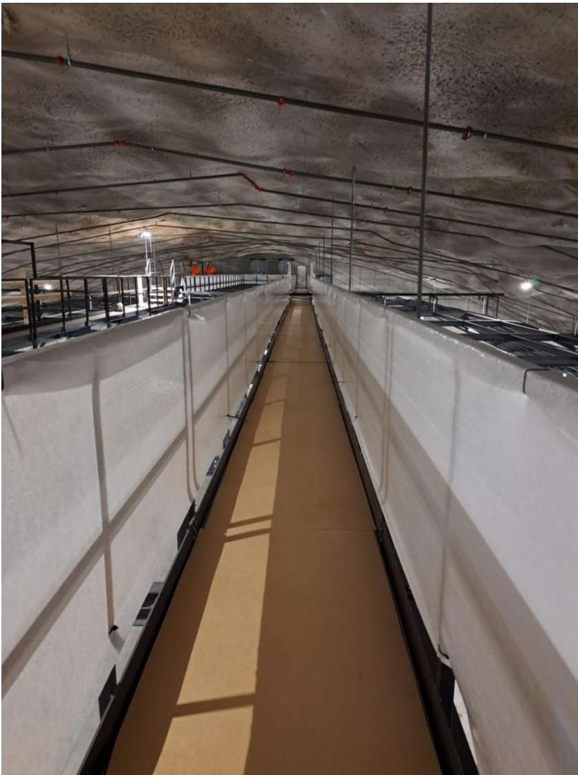
H1: yhteiskannakoinnin yläpuolelle valmistunut huoltosilta suojattuna.
