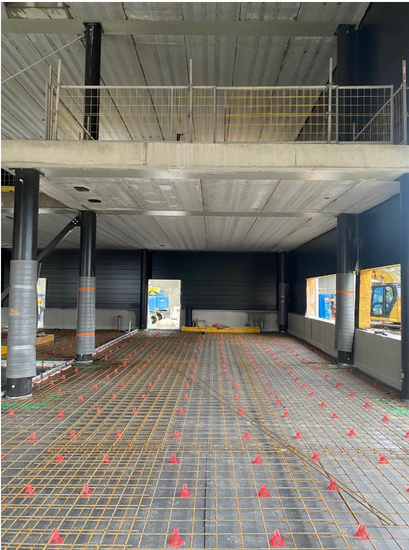
R1: lattian raudoitustyöt käynnissä.
