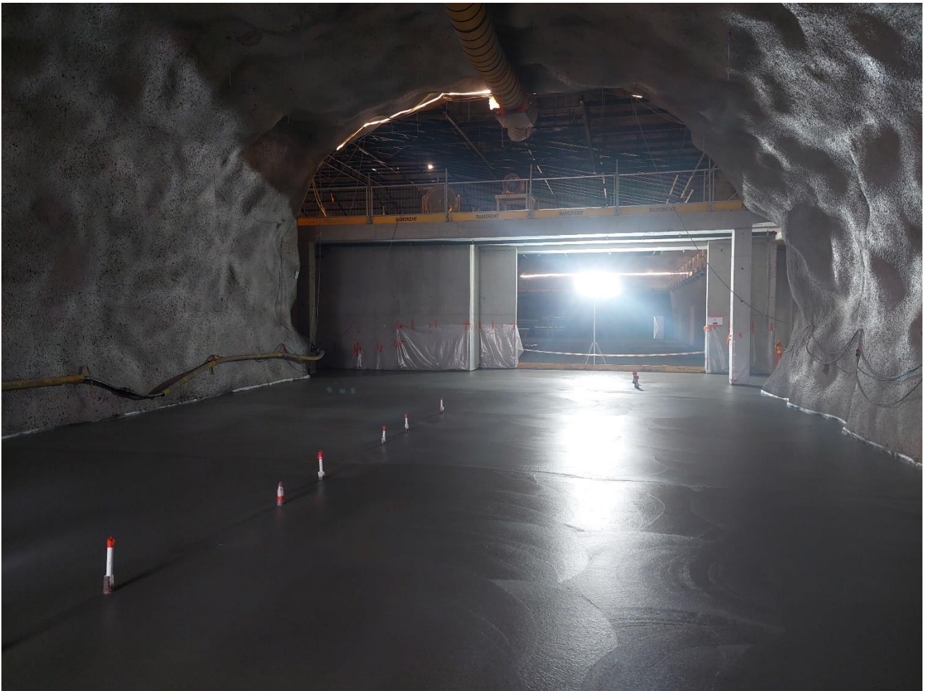
H1 ja T6 lattiavalut valmistuivat tällä viikolla.
