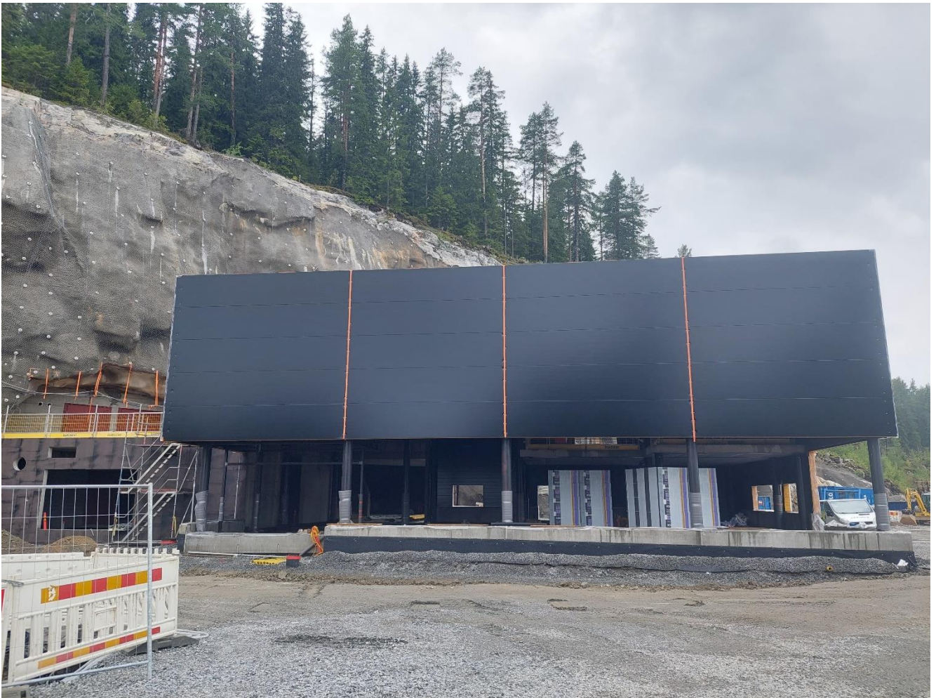
R1: PVP-elementtiasennukset ovat valmistuneet.
