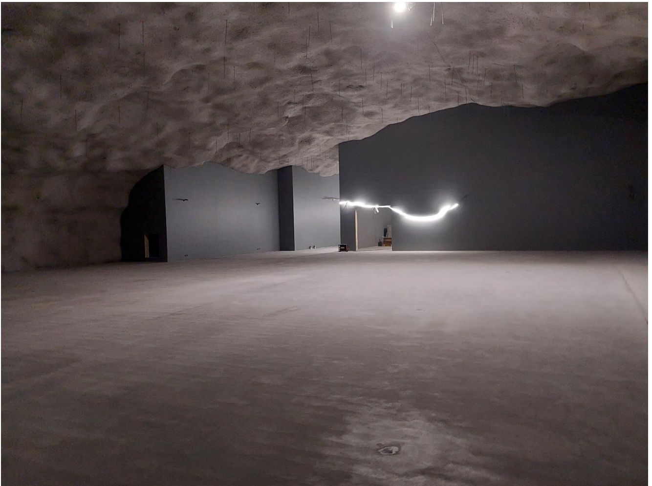
H2: 2. kerroksen alue valmiina ilmanvaihtosennuksia varten.
