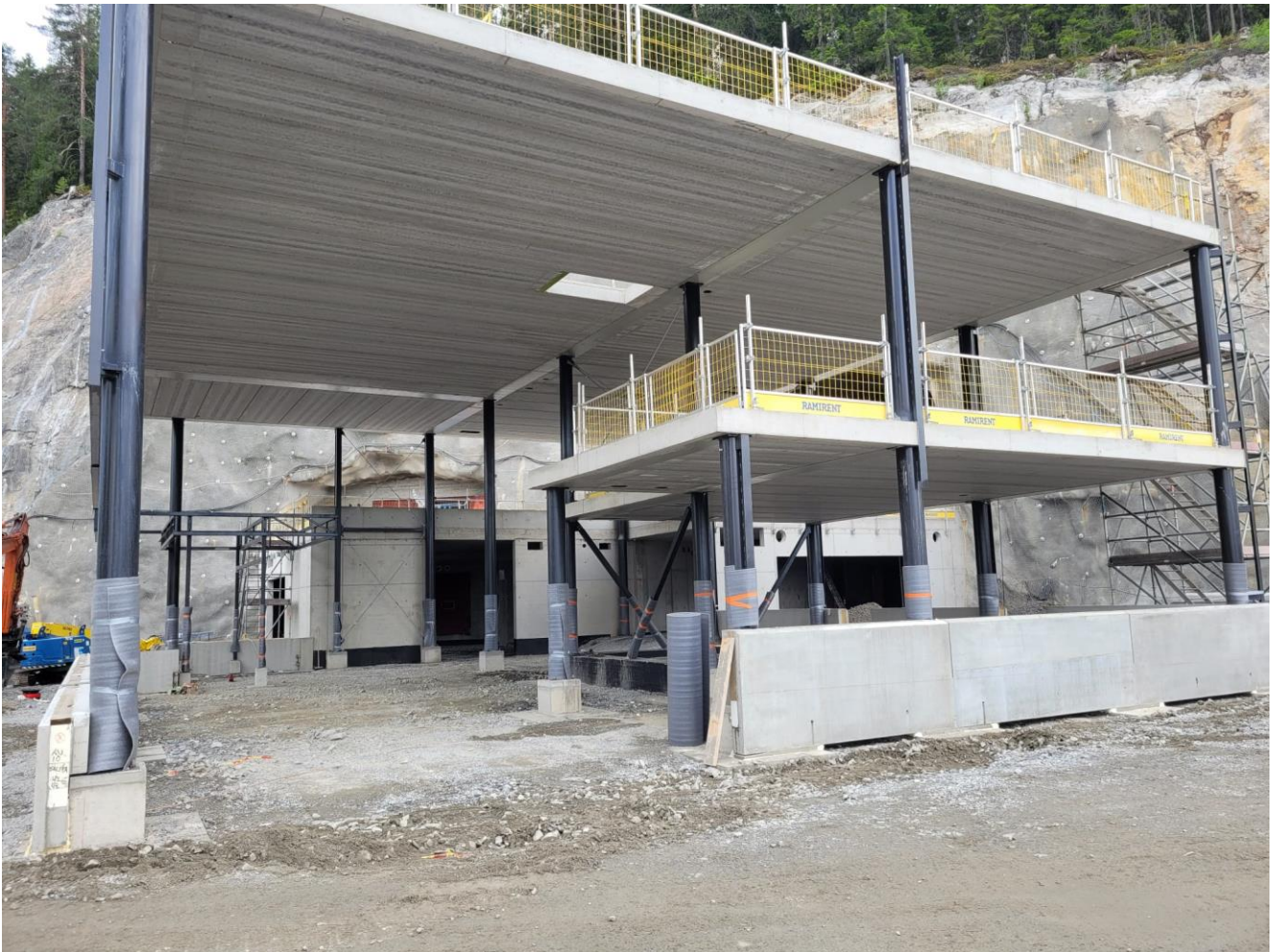
R1: sisäänkäyntirakennuksen sisätäytöt valmiina alkamaan.
