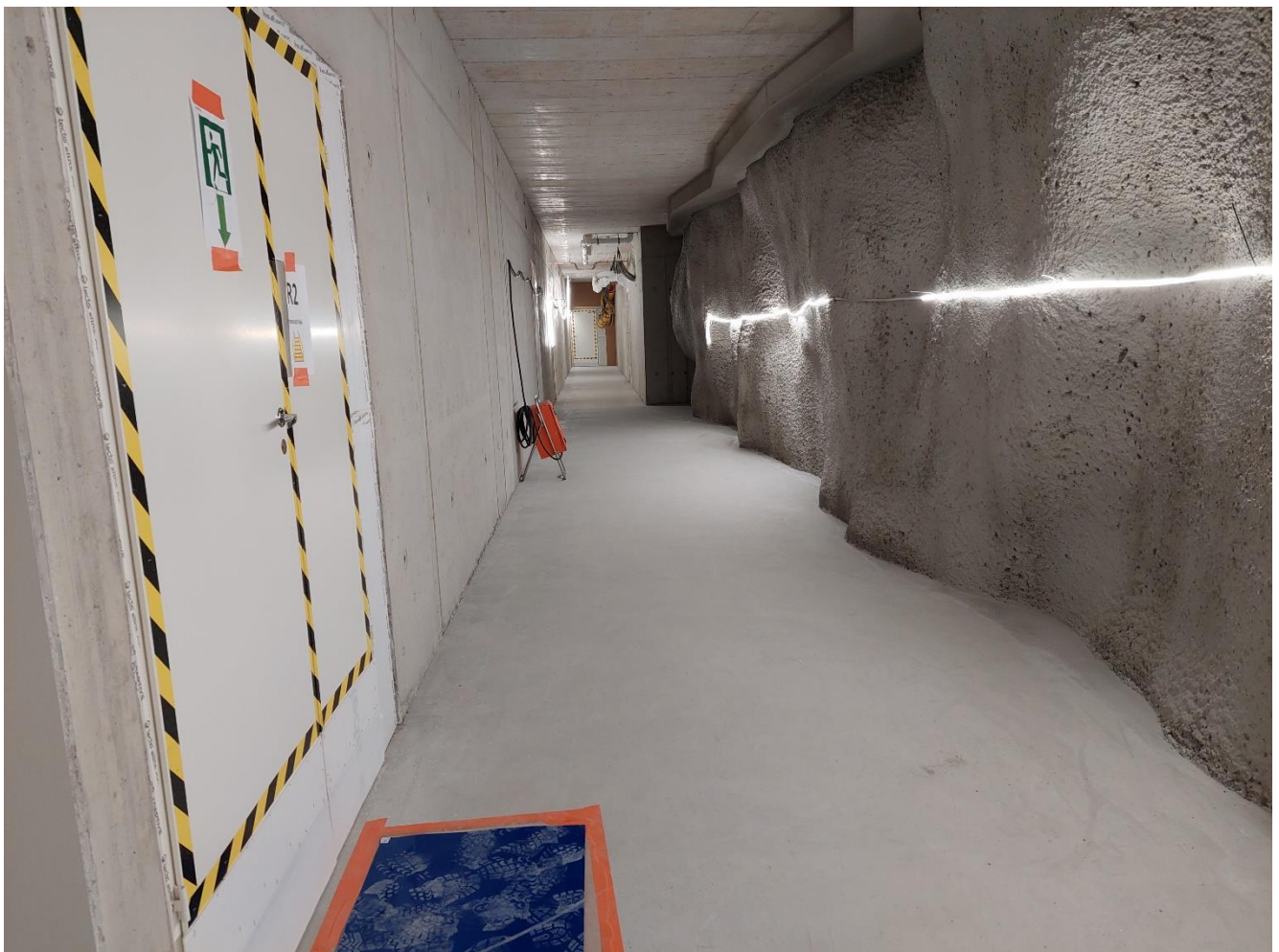
R2: 2. kerros valmiina ilmanvaihtoaennuksiin.
