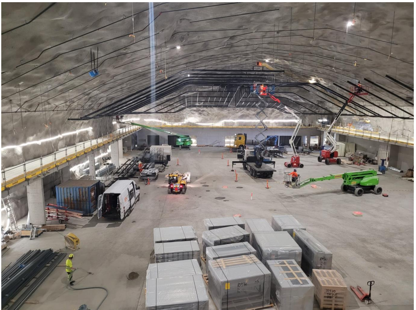
H1-alueen yhteiskannakointijärjestelmän asennus käynnissä.
