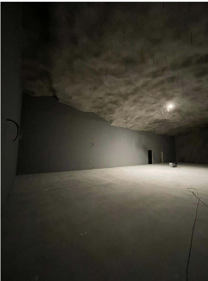
H2: 2 kerroksen maalaustyöt ovat pääosin valmistuneet.
