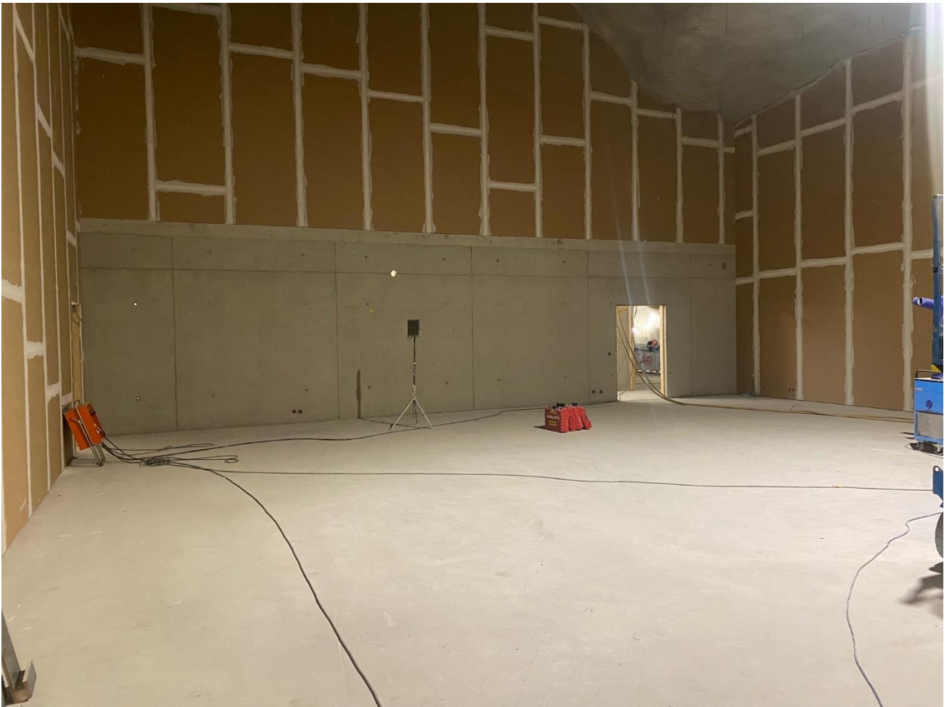
H2: 2. kerroksen seinien tasoitustyöt käynnissä.
