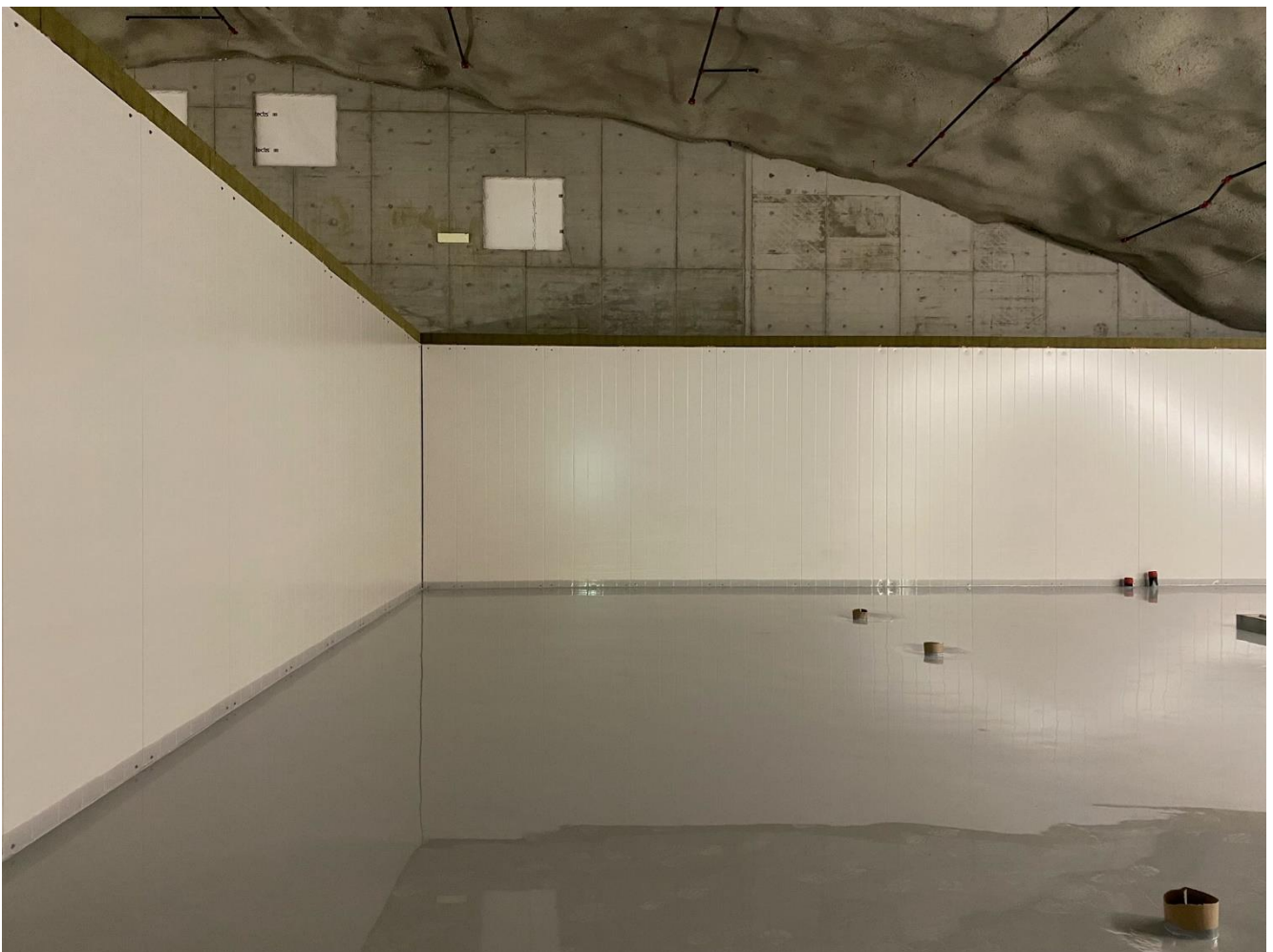
IV-konehuoneessa lattiapinnoitus valmistunut.
