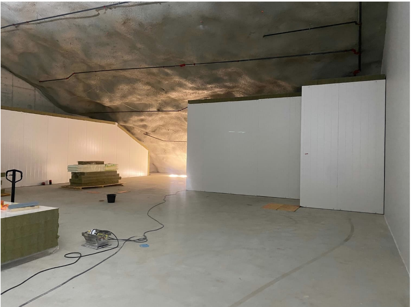
R2: IV-konehuoneessa seinätyöt käynnissä.
