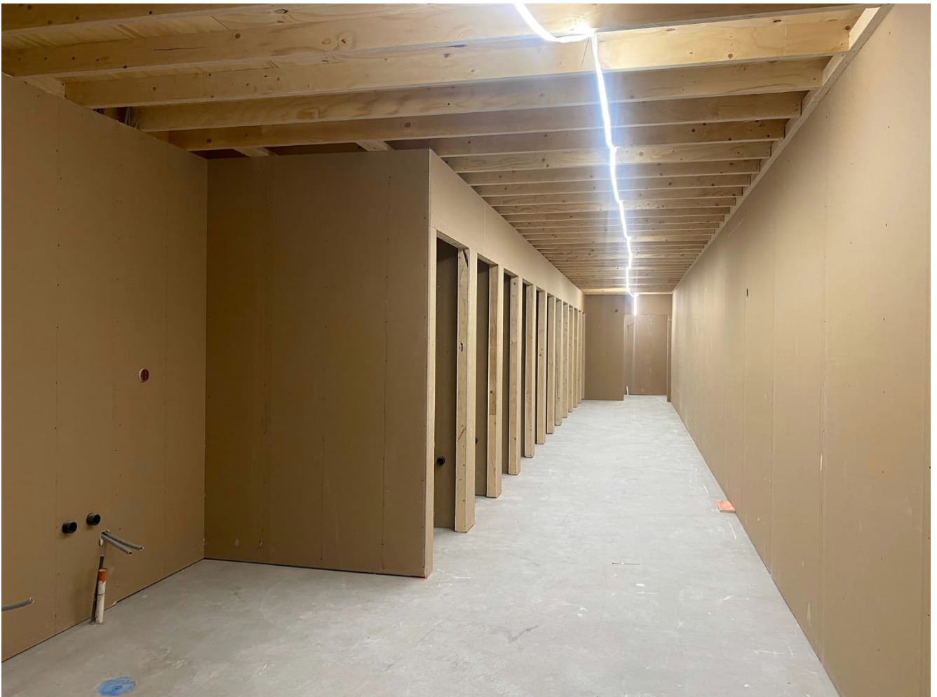
H2-alueen kipsiväliseinätyöt valmistuneet.
