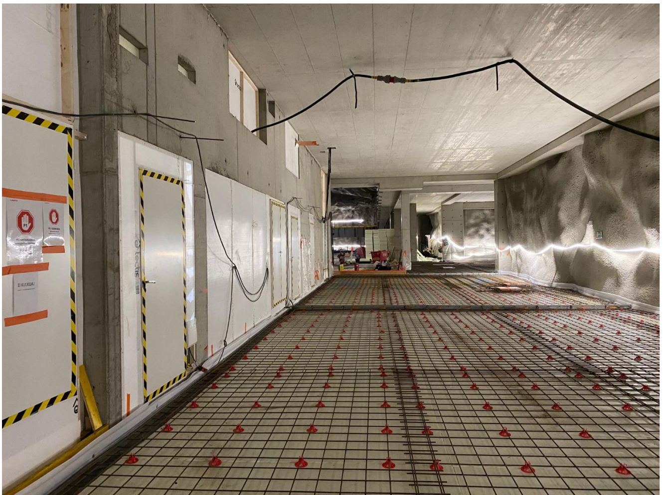
T4 ja T3 välisellä alueella lattiatyöt käynnissä
