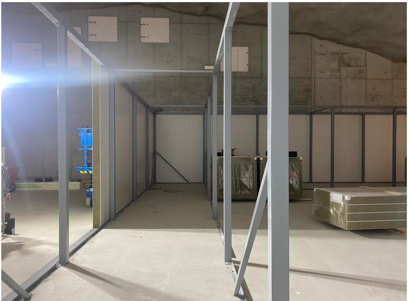
R2: 3. krs terästyöt ja Paroc-asennukset käynnissä
