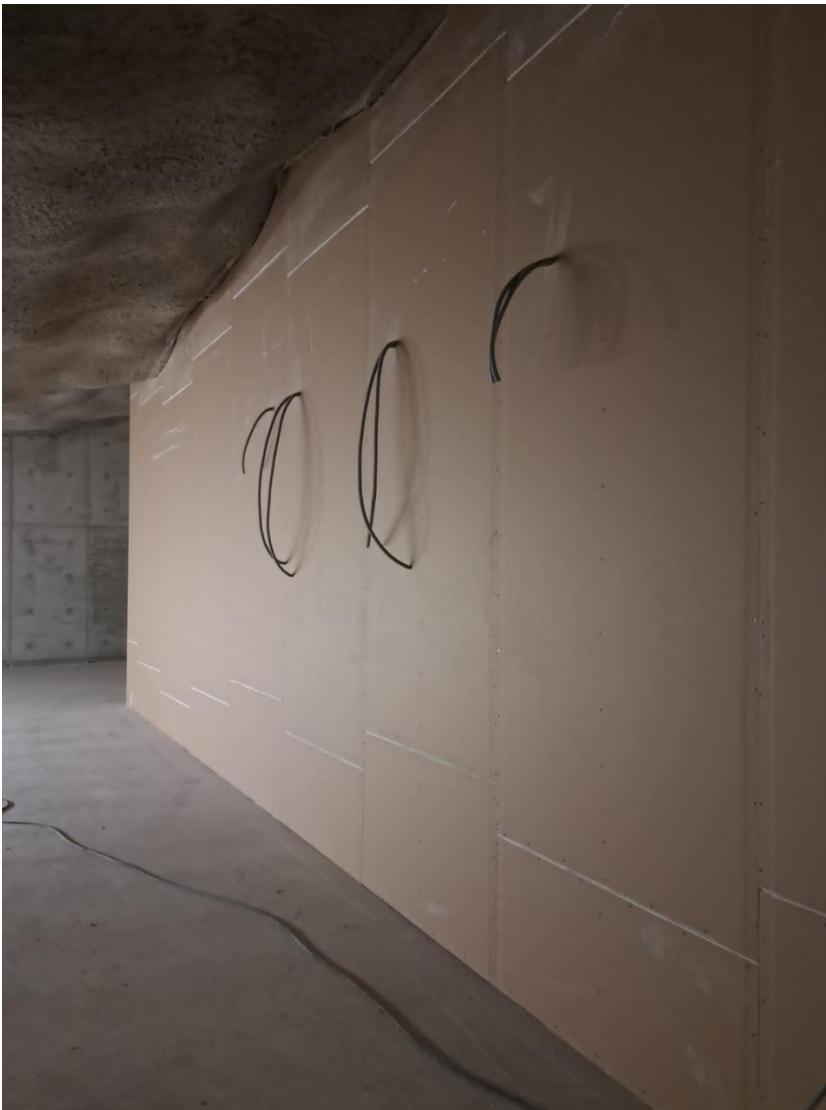
Kuva 2: H2 väliseinätyöt etenevät.
