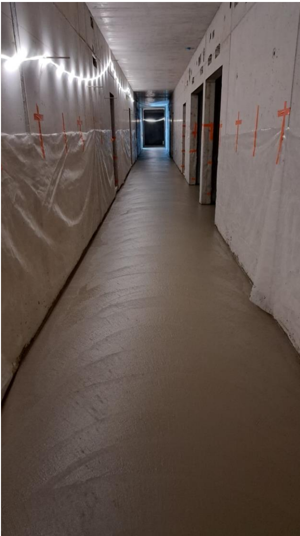
Kuva 1: R2 käytäviä valettu.
