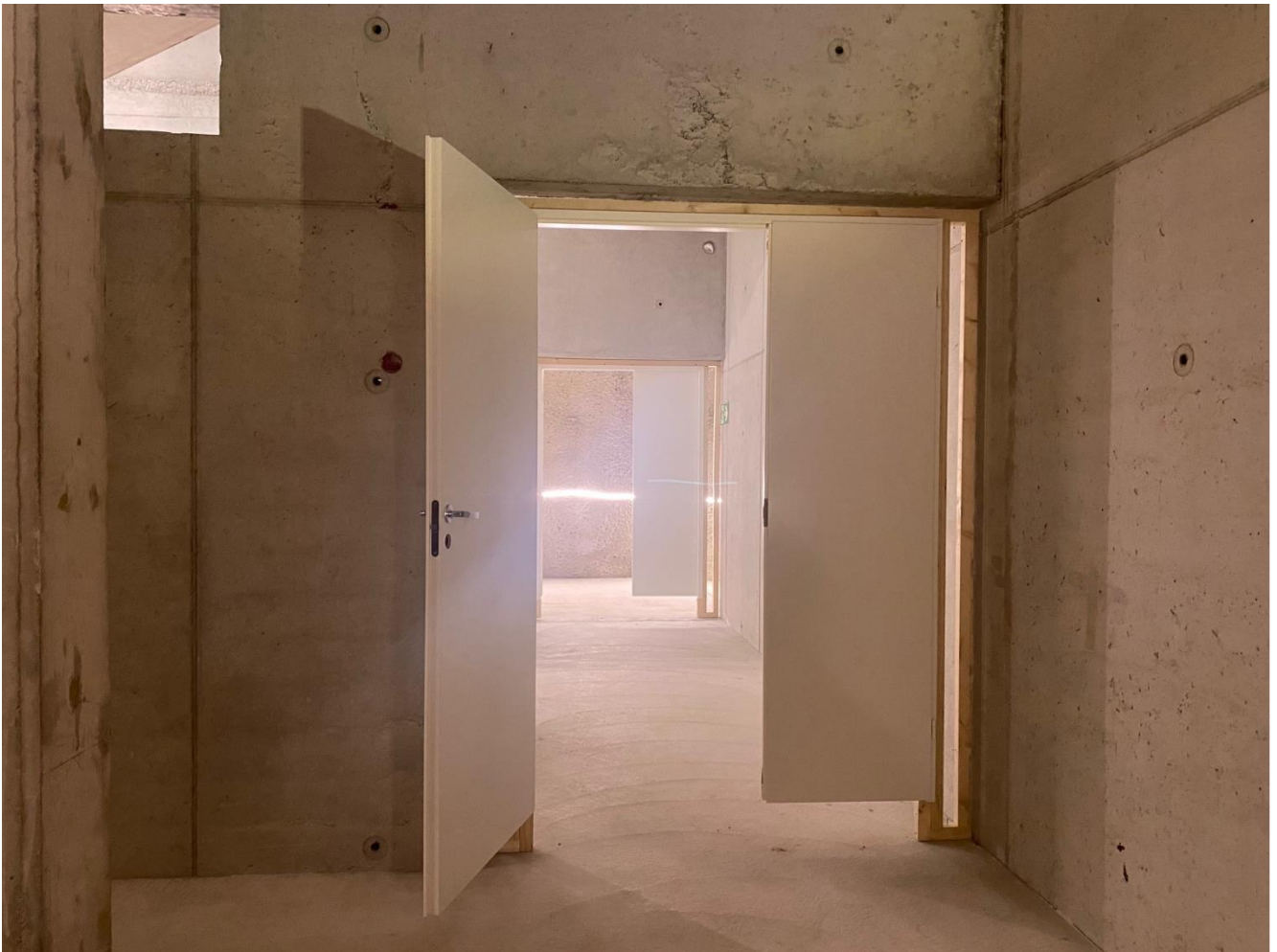
Kuva 3: työmaalla asennettu väliaikaisia osastoivia ovia.
