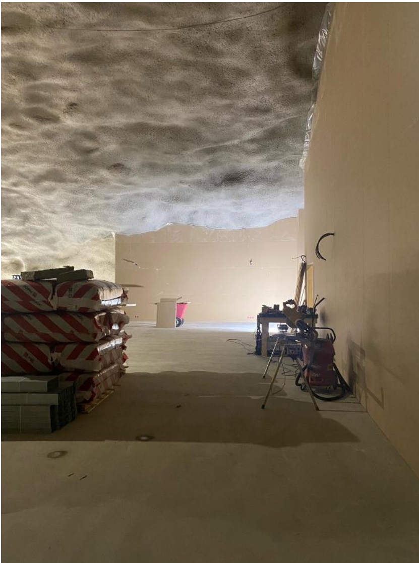
Kuva 1: H2 2. krs väliseinätyöt.
