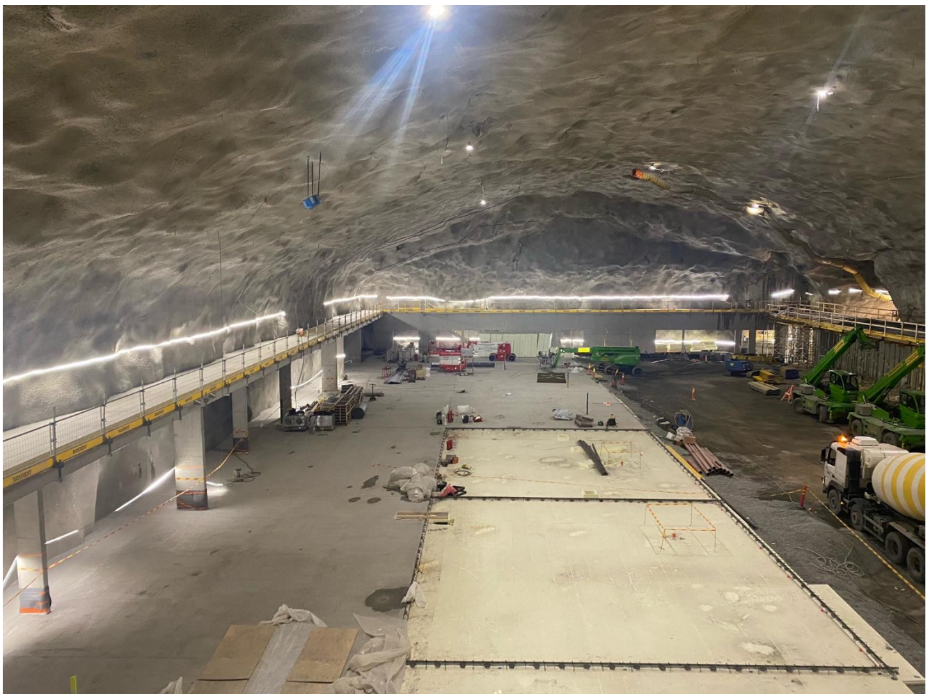
Kuva 3: H1-alueella lattiatyöt käynnissä.
