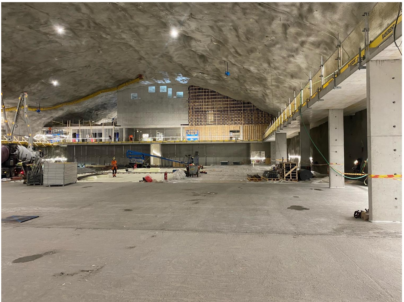
Kuva 3: H1 lattietyöt ja kuvan perällä R2 3. krs seinän työt käynnissä.
