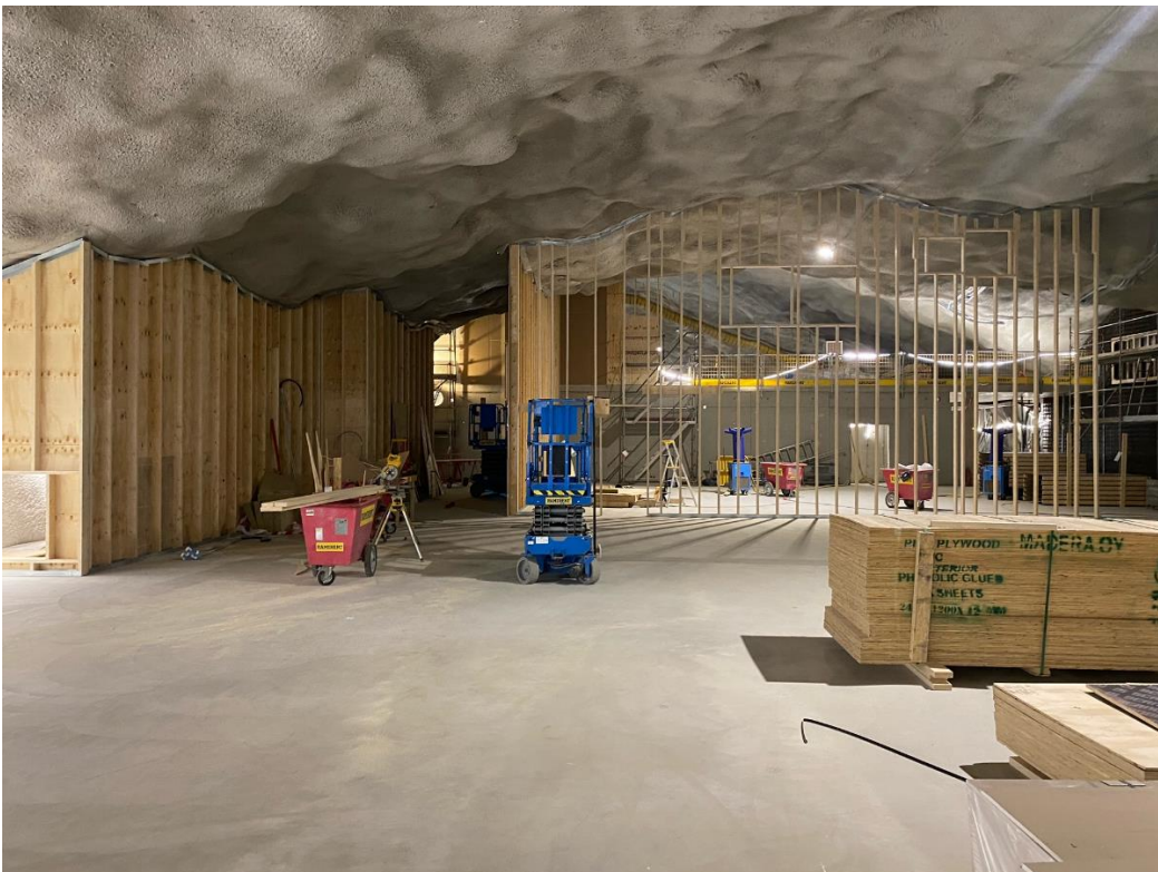
Kuva 1: H2 2. krs väliseinätyöt.
