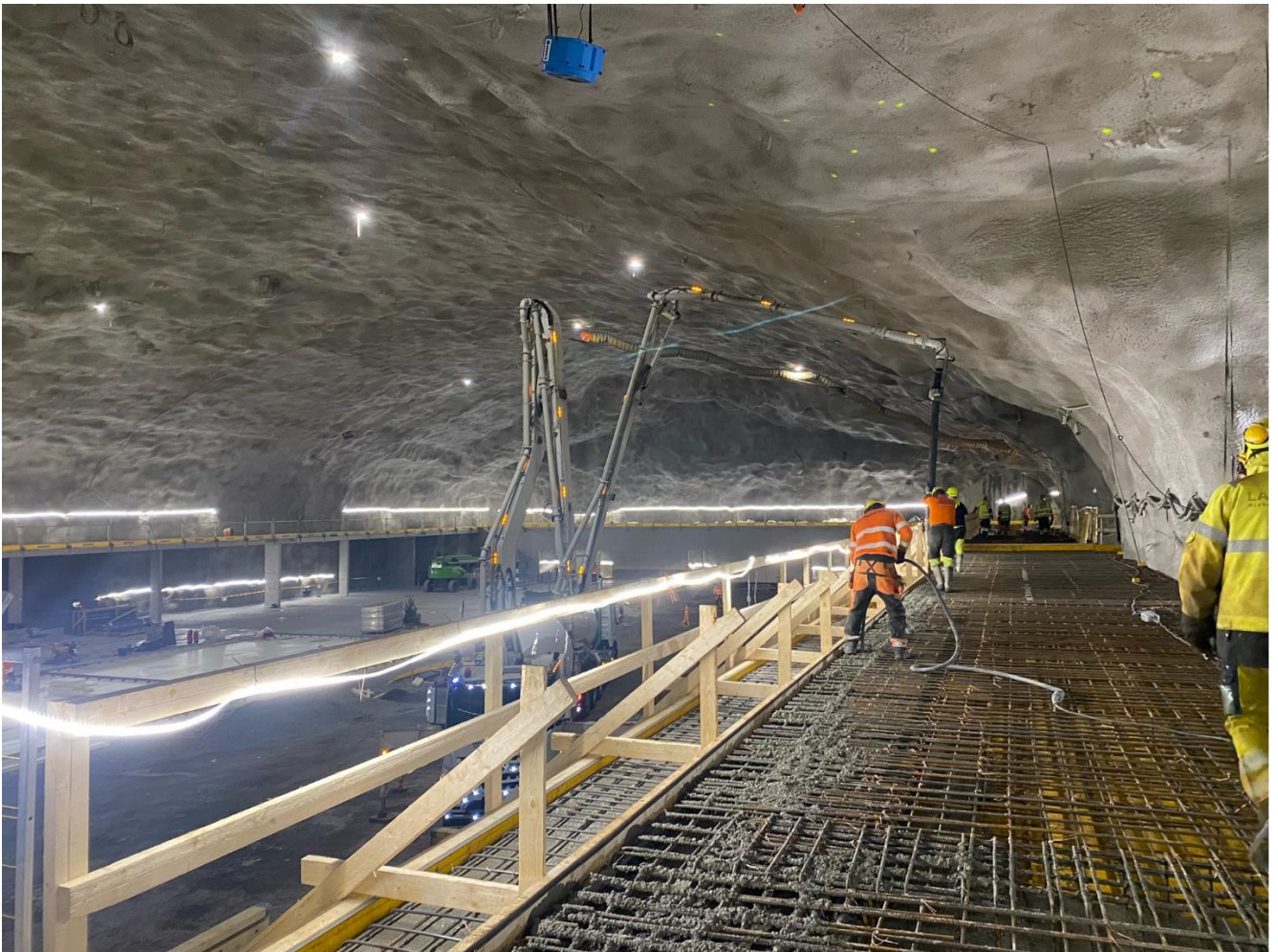
Kuva 2: T4-T6 tunnelien edessä holvin teko.
