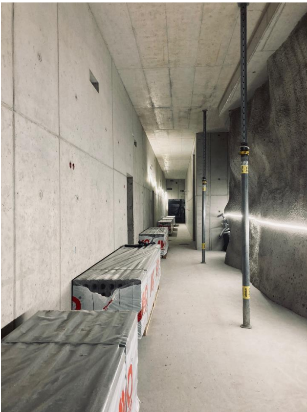
Kuva 1: R2 1. krs käytävä.
