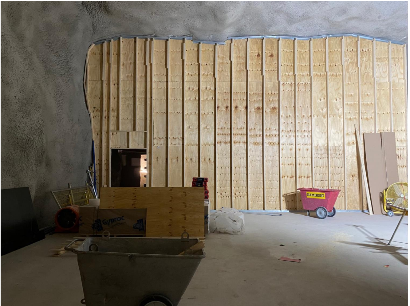
Kuva 3: R2 ja H2 alueella kipsiväliseinät työt käynnissä.
