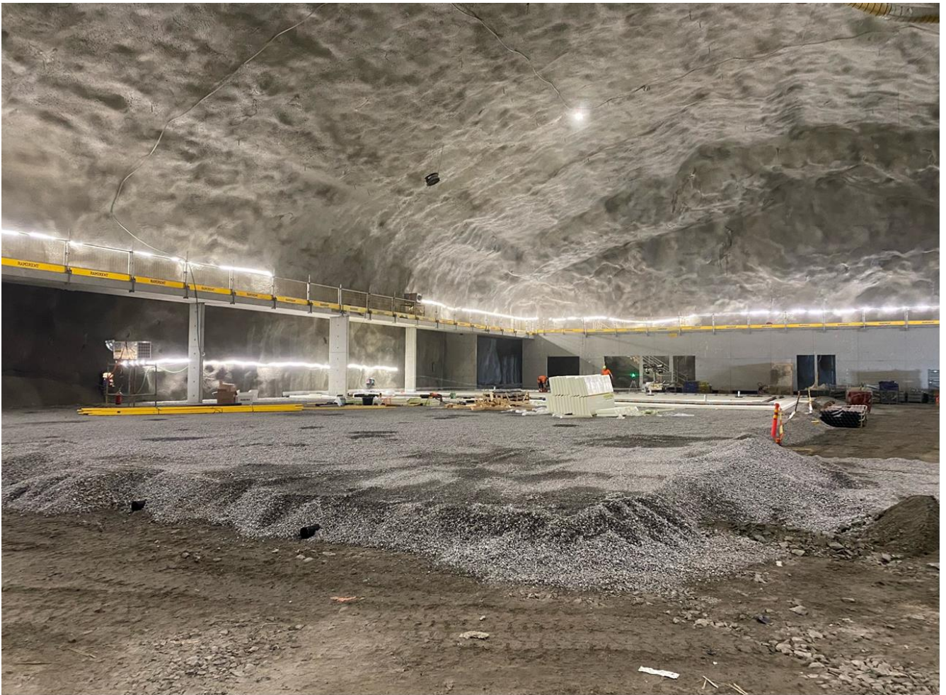
Kuva 2: H1 lattiatyöt käynnissä.
