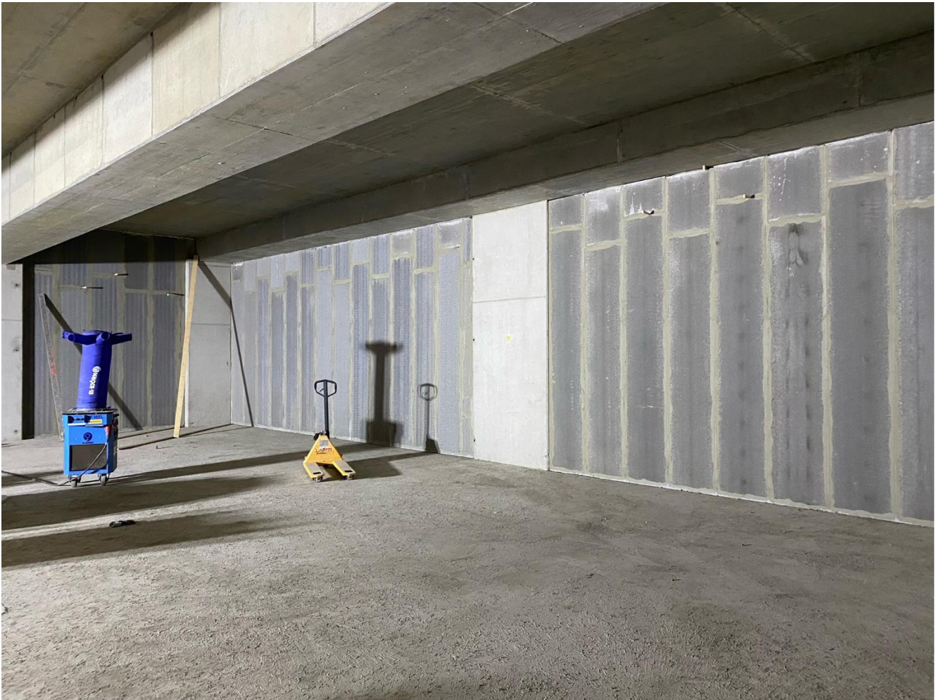
H2 alueella Akoseiniä asennettu.
