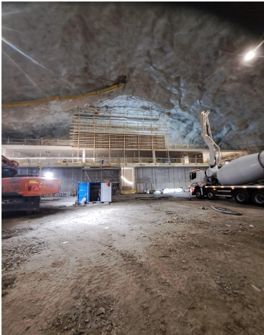
R2 3. krs seinän muottityöt käynnissä.
