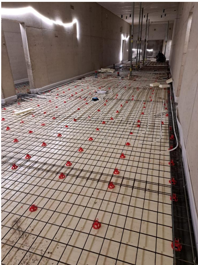
R2 lattialämmitysasennukset aloitettu.
